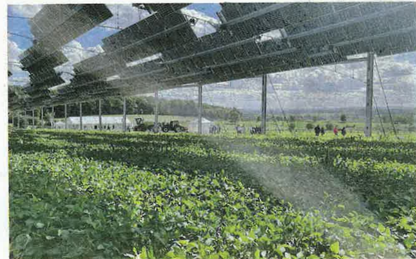
La Canopée agricole, une ombrière photovoltaïque rotative suspendue à 5 m du sol permettant le passages des engins agricoles.
