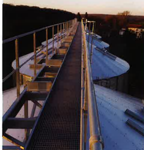
silos de stockage de Fontenois les Montbozon
