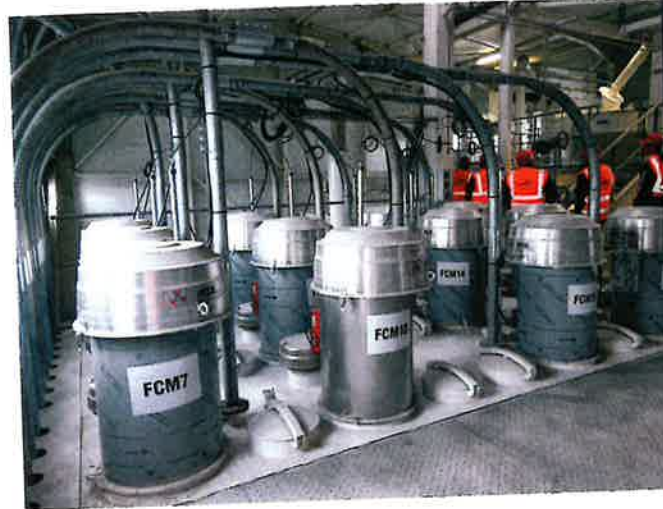
L'usine compte 18 cellules de micro-ingrédients (minéraux).
