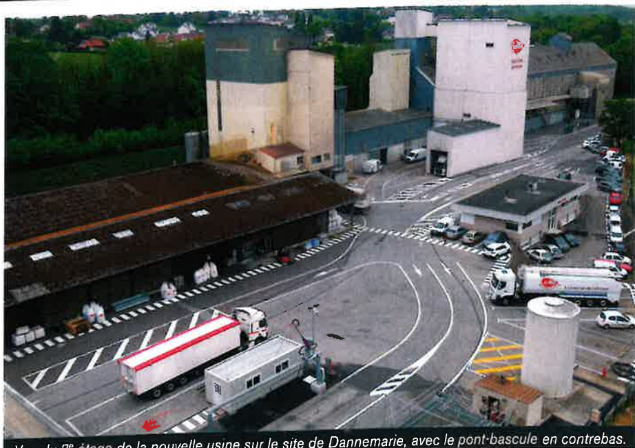
Vue du 7 e étage de la nouvelle usine sur le site de Dannemarie, avec le pont-bascule en contrebas.
