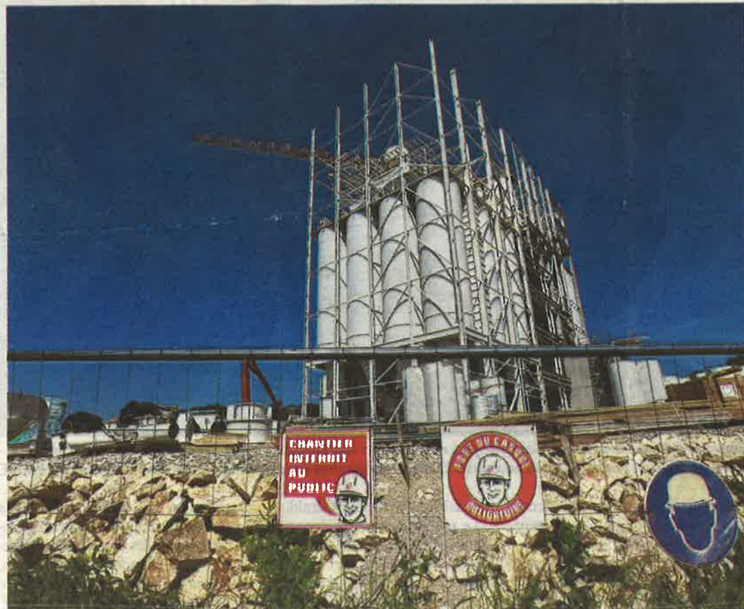
Le squelette de la future usine à aliments sera bientôt recouvert. Photo Franck HAKMOUN
